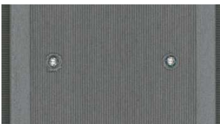
Productieresten bij de schroefverbindingen van de JUMBO WPC-profielen
